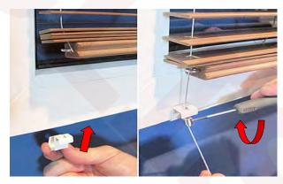
8. Den Clips unten am Fensterflügel befestigen. Die Befestigungsbuchse auf das gezogene Führungsseil aufsetzen und dann die Schraube in der Buchse festziehen (an beiden Seiten der Jalousie wiederholen).
