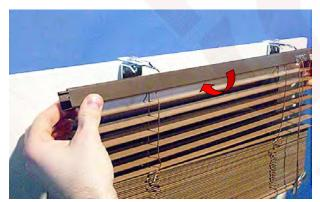
Die obere Rinne in die Haken einrasten lassen (mit dem Griff mit einer Drehbewegung von vorne nach hinten).
